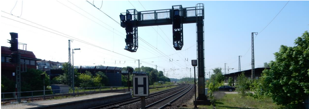
(Station Lüneburg, richting Uelzen)
