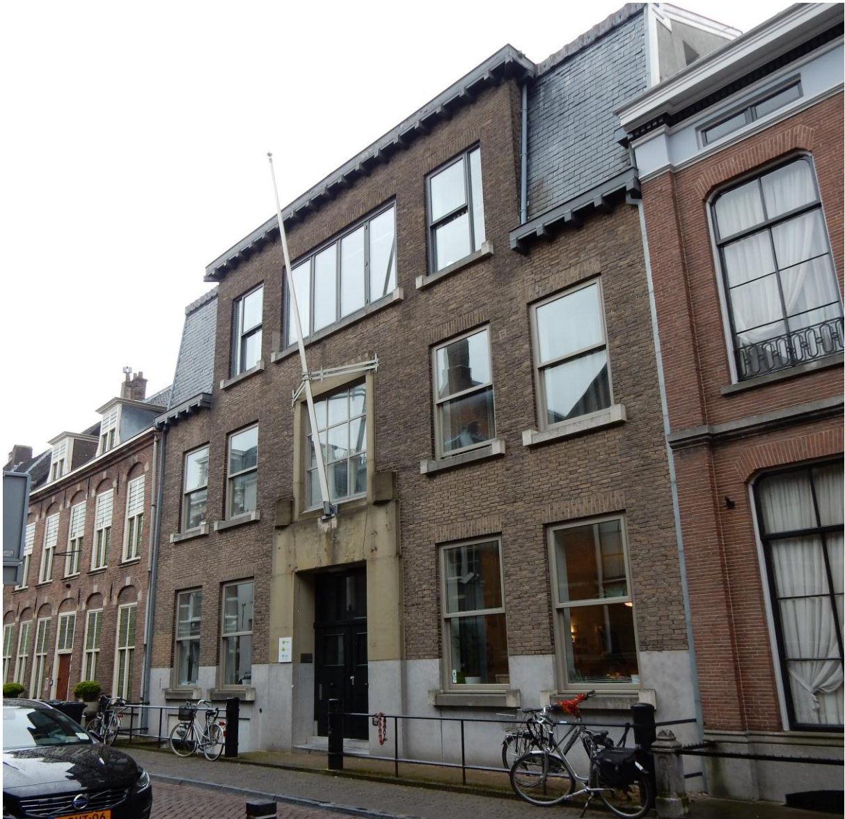
Zuilenstraat 7: Gebouw van de voormalige basisschool [vgl. http://www.hetutrechtsarchief.nl/beeldmateriaal/... ]
